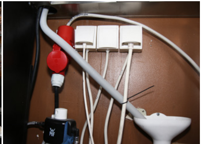
Die Kaffeemaschine und rechts der Blick unter den Tresen: Dort mündet der Abwasserschlauch in einem Trichtersiphon.
