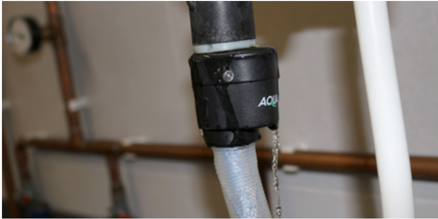
Der Geschirrspüleranschluss bei der Dichtigkeitsprüfung im IFS
