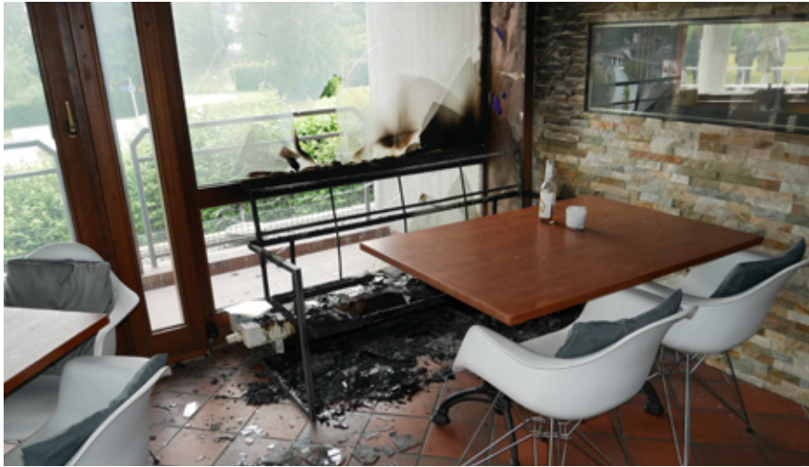
Die Polsterbank vor dem Fenster ist bis auf das Metallgerüst verbrannt. Dahinter ist die Fensterscheibe durch die Brandhitze geplatzt.
