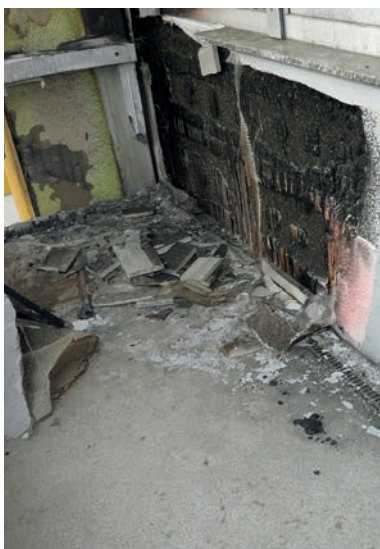
Hier ist auf einem Balkon die gedämmte Fassade eines Mehrfamilienhauses in Brand geraten. Rechts: Der Gutachter entnimmt eine Probe des Dämm-Materials.
