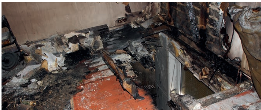
Wo das Loch im Fußboden zu sehen ist, hat vorher ein Sofa gestanden. Ein Raucher hatte eine Kippe auf dem Polstermöbel verloren.
