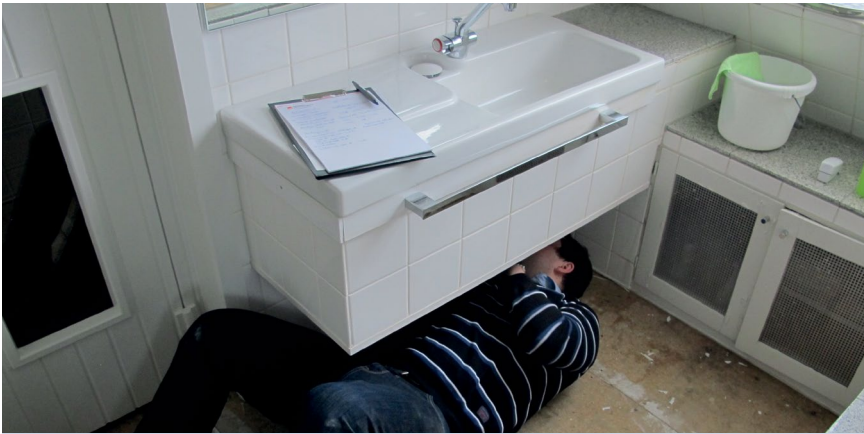
Leitungswasserschäden werden vom IFS auch vor Ort untersucht.
