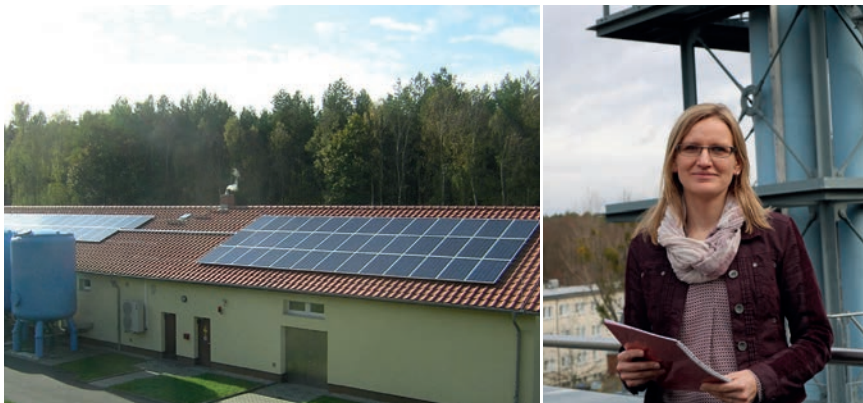
Tina Sendler von der EWP hat große Projekte im Blick und auch kleine, wie die Photovoltaikanlage auf dem Dach eines Potsdamer Wasserwerks.
