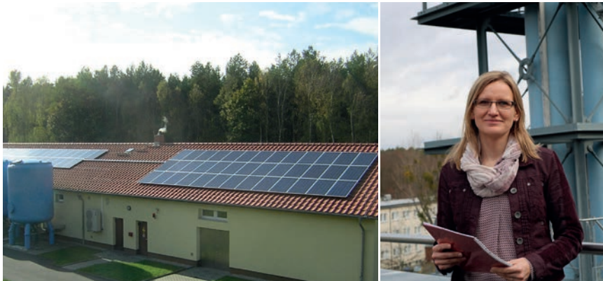
Tina Sendler von der EWP hat große Projekte im Blick und auch kleine, wie die Photovoltaikanlage auf dem Dach eines Potsdamer Wasserwerks.
