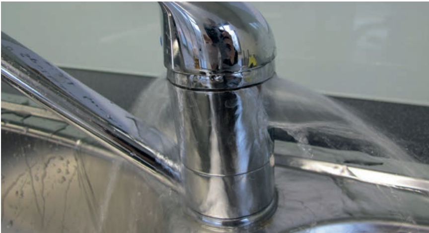
An dieser Stelle sollte das Wasser besser nicht aus der Armatur laufen.
