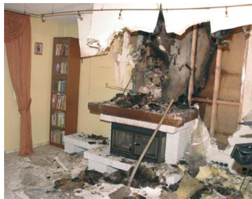
Der Kamin aus dem hier beschriebenen Fall
