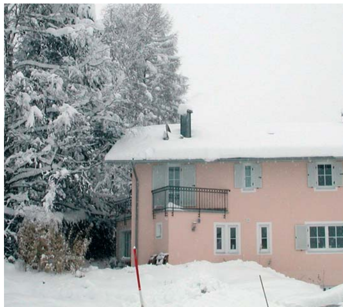
Leitungen im und am Haus sollten richtig und rechtzeitig vor Frost geschützt werden.
