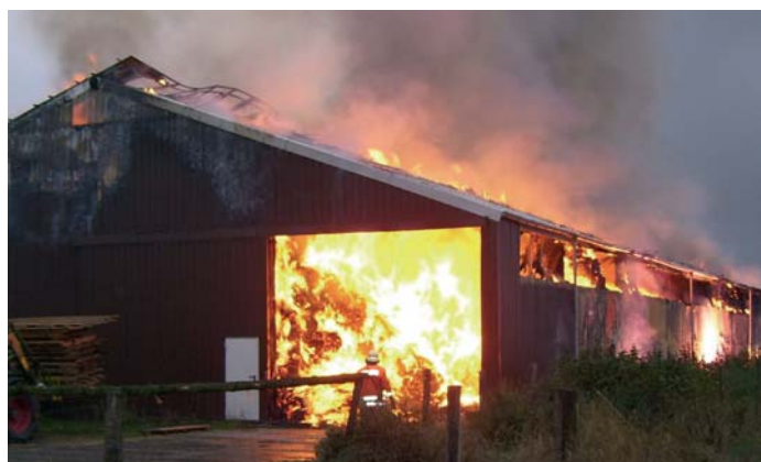
Die Feuerwehr kann den Ausbrand der Halle nicht verhindern.
