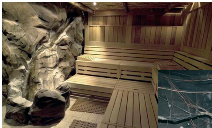
Die Sauna vor und nach dem Schaden. Im oberen Bild sind einige der Kopfstützen zu sehen, von denen eine in den Warmluftspalt gefallen war.
