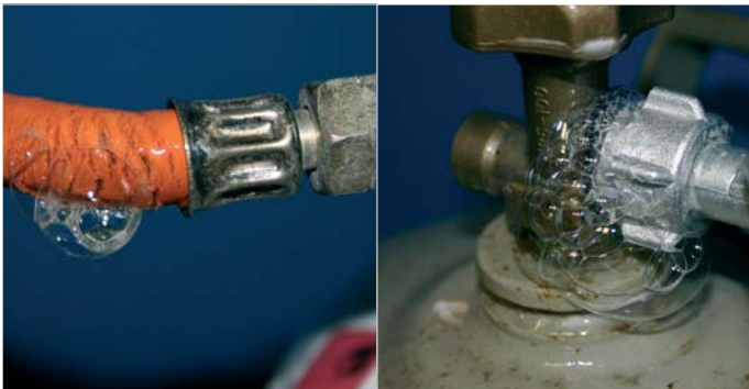
An der Blasenbildung in der Seifenlauge sind deutlich die Undichtigkeiten am Gasschlauch und dem Ventil der Flasche zu erkennen.
