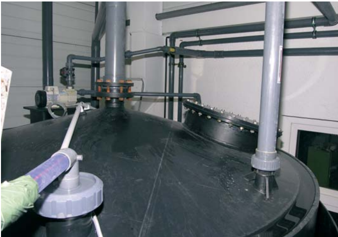
Das Dach des Tanks: Vorn links im Bild ist die Füllstandsanzeige zu sehen.
