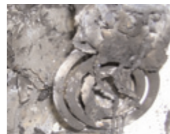
Die Reste der Heizspirale
