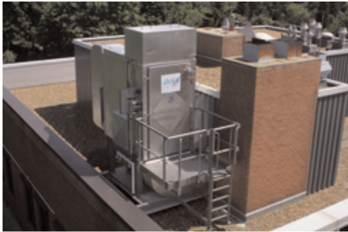
Der Blick auf das Dach des IFS-Gebäudes in Kiel mit der Filteranlage
