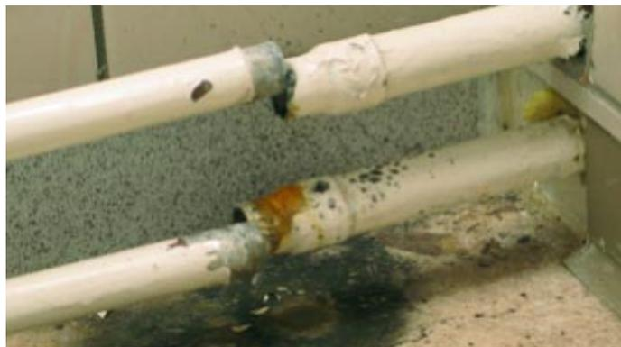
Durch Frosteinwirkung wurden die verlöteten Rohre an den Muffen auseinandergedrückt.
