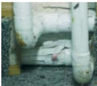
Das Kupferrohr hat sich durch den Frost aufgebläht; die Farbe ist abgeplatzt.
