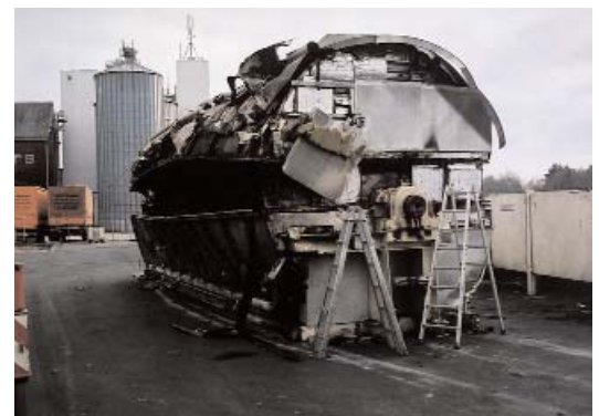
Durch die Staubexplosion und die übergreifenden Flammen wurden der Trebertrockner und eine angrenzende Halle völlig zerstört.
