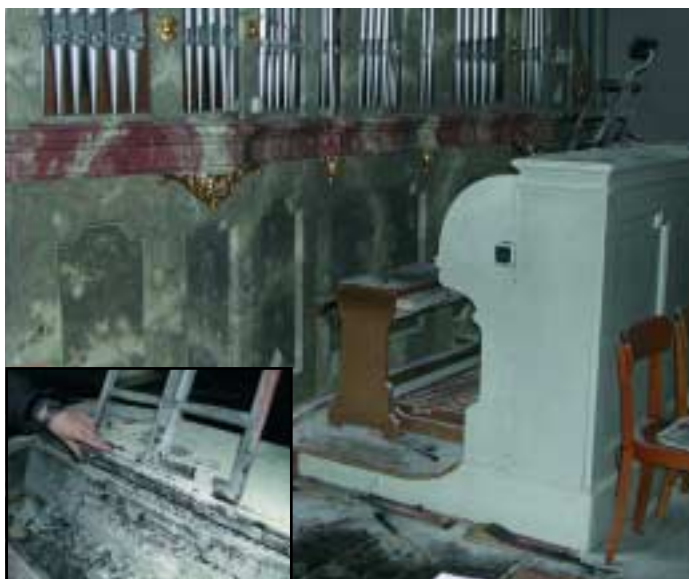
Die betroffene Orgel. Das kleine Bild zeigt die Stelle, an der der Heizstrahler montiert war.
