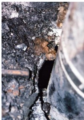
Der Abstand zwischen Rohr und Holz
