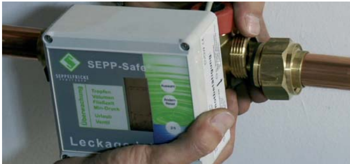
Im Filmbeitrag wird die Installation des Absperrventils gezeigt.
