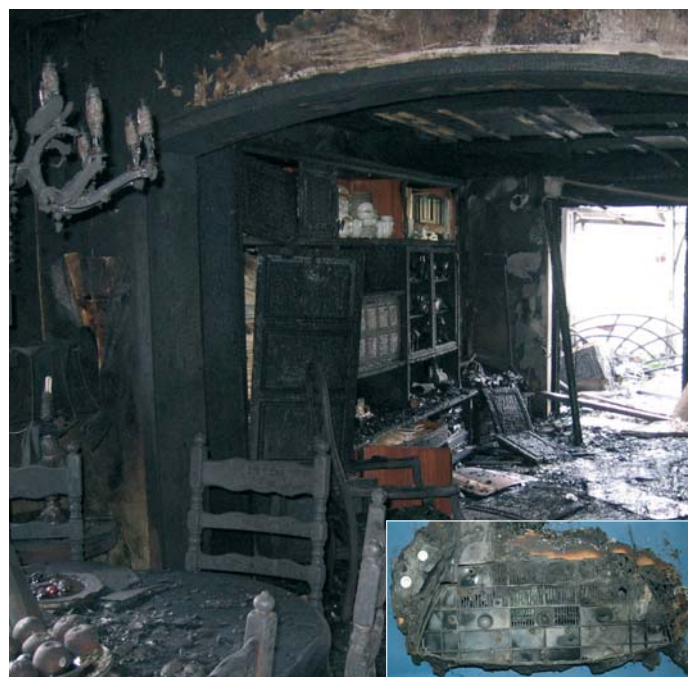
Das Wohnzimmer, Schadensschwerpunkt am TV-Gerät (kl. Bild)
