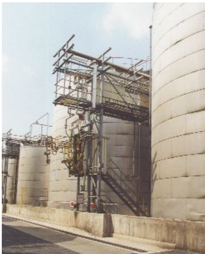
In diesen Tanks eines Chemiebetriebes lagern mehr als 4000 Tonnen unbrauchbare Produkte im Wert von 1,2 Mio. Euro. Sie entstanden aufgrund fehlerhafter Ausgangsstoffe eines Versicherungsnehmers.
